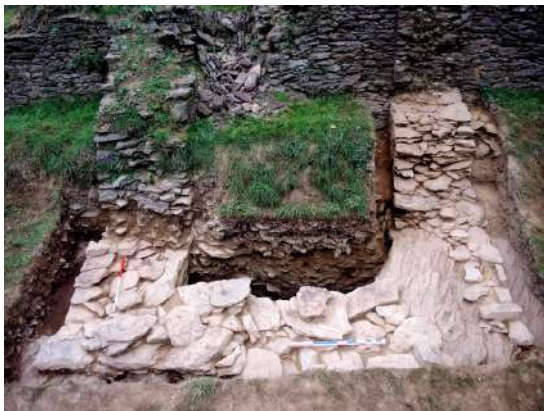
Base d'une tour avant restauration
